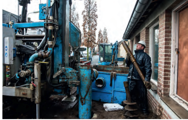
Voor de brine/waterwarmtepomp van een woning wordt de aardwarmtebron geboord.
