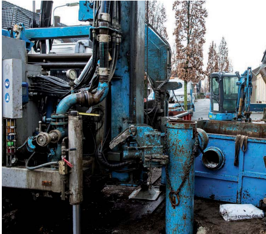
△ Voor de brine/water-warmtepomp van één woning wordt de aardwarmtebron geboord.
