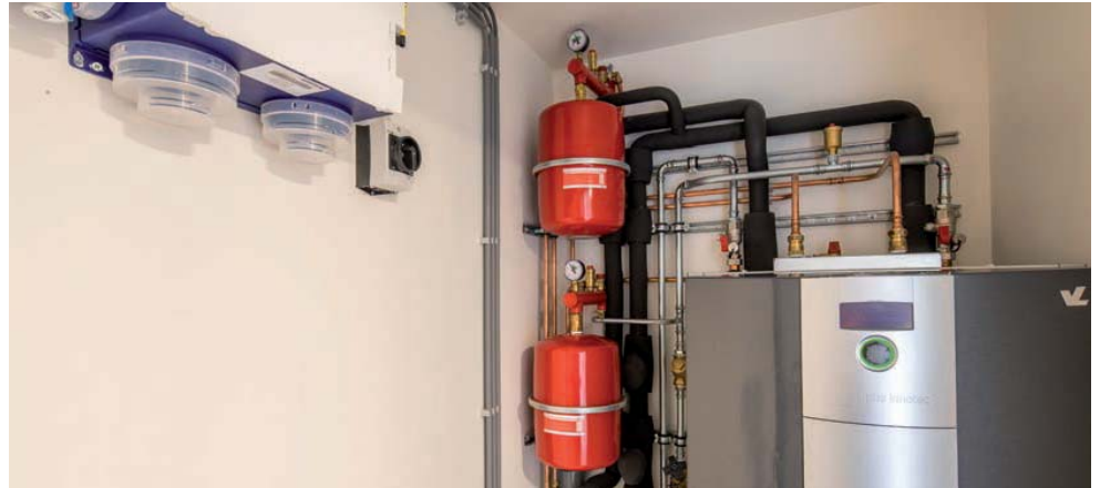
△ Bodemwarmtepomp van Alpha Innotec en de Nederlandse primeur van de Healtbox 3.0 van Renson.
