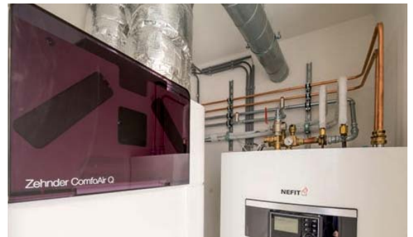
△ Andere woning met lucht/water warmtepomp Enviline van Nefit, gecombineerd met een Zehnder WTW.
