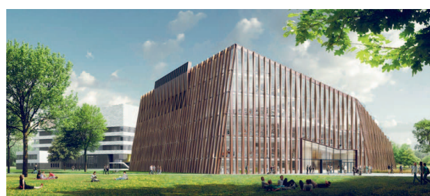
Nieuwbouw Energy Academy Rijksuniversiteit Groningen bron: rug.nl/groundbreakingwork/projects/ea
