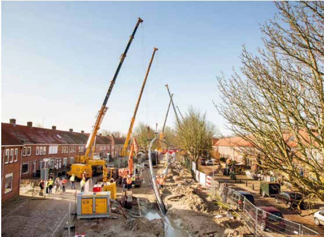
Werkzaamheden aanleg Warmtenet Alkmaar, HVC.
